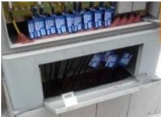
图二：交接箱进线孔应进行封堵，避免虫蚁等进入箱内，损坏箱内措施
