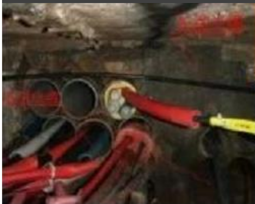
图四：井必须用竹梯,尽量避免触碰和踩踏现有线缆，对现有线缆用保护材料进行包裹保护
