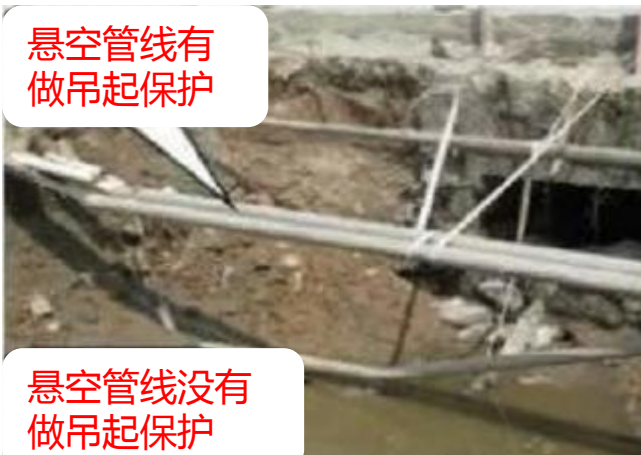
图四：在复杂区域开挖时，应注意地下管线的保护，避免损坏引发中断。
