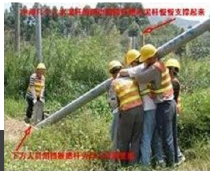
图三：抬杆尾时要注意抬杆两边人员用力均匀，用力不均匀会导致水泥杆往一边倒,致使水泥杆破裂或者压到人。
