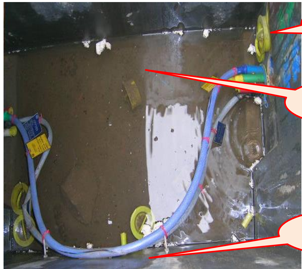
管孔封堵完好
