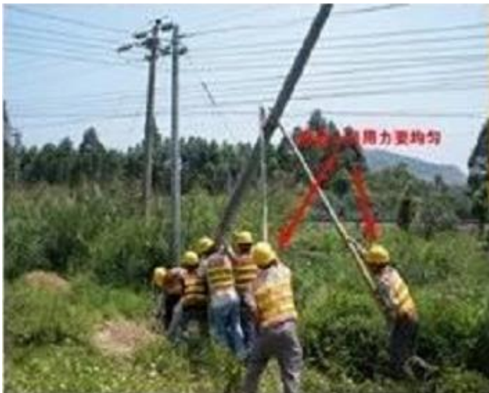
图二：立杆时，杆头下方人员要有挡板把杆头导入杆中洞里面，中间几个人水泥杆的两边用撑杆把水泥杆慢慢支撑起来。
