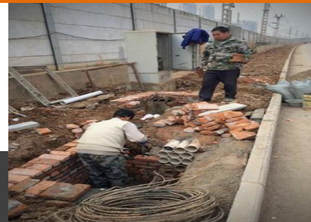
图一：管道周边是施工路段，是否安排有三盯人员上报盯防信息，是否安放明显的警示标识
