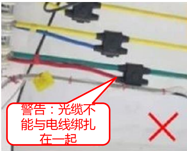
图三：光缆不能绑扎在供电线上。
