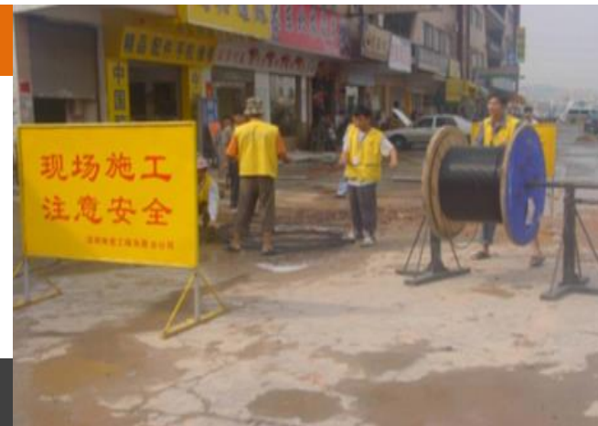
图二：施工区域摆放警示标志。
