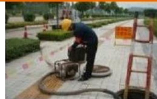
图二：发动机、抽水机应摆放在下风处,避免废气损害健康;严禁给工作中的机器加注燃油
