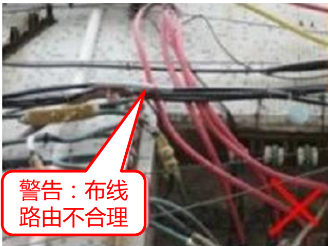
图一：光缆敷设与供电等其他线缆交越时要安装交越保护套管。
