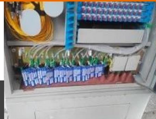
图三：施工作业拉断邻近光纤、尾纤，造成通信系统中断
