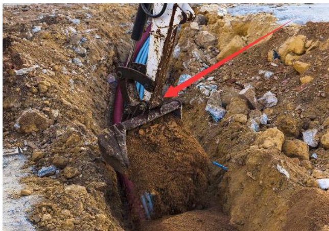
图四：管道周围存在顶管，必须安排人员盯控
