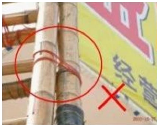
图三：严禁接驳竹梯，应该选用合适高度的梯子
